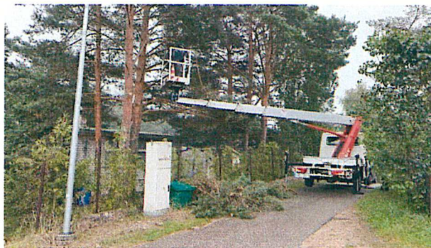
1.4.2. attēls. Ielu apgaismojuma līniju tīrīšana no zariem gaisvadu tuvumā
