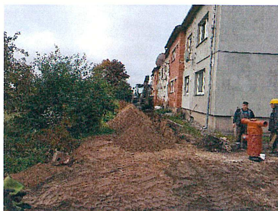
1.4.3.attēls. Izbūvēta kanalizācija Garcieņa dzelzceļa stacijas daudzdzīvokļu ēkām
