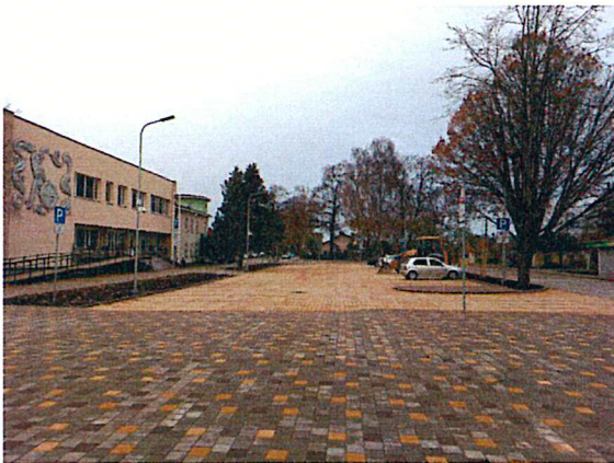
1.4.1. attēls. Stacijas ielas rekonstrukcija
