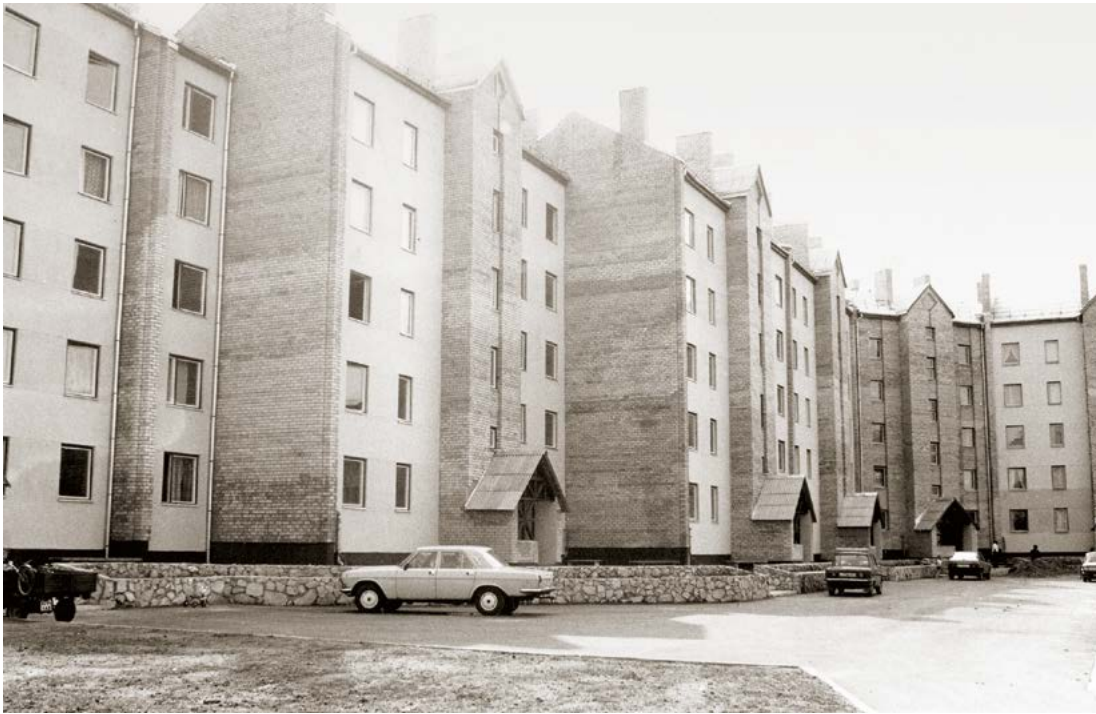
◀ Arhitektoniska uzdrīkstēšanās vienmuļajā padomju laika apbūvē – dzīvokļu mājas Ādažu centrā. 20. gs. 80. gadi. A. Bindera foto. (No Ādažu muzeja krājuma)
