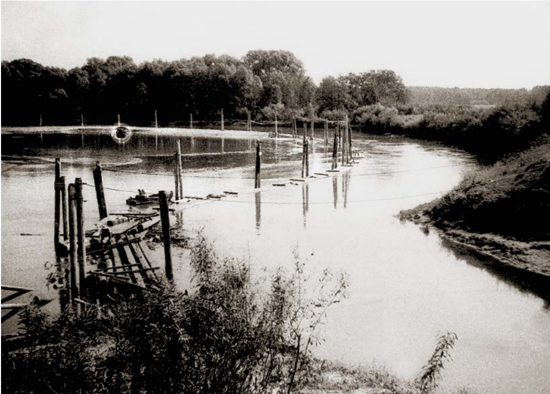
◀ Gaujā izbūvētā īpašā koka konstrukcija – ievadragata – baļķu novirzīšanai uz Baltezera kanālu. 1958. gads. M. Mitrēvica foto
