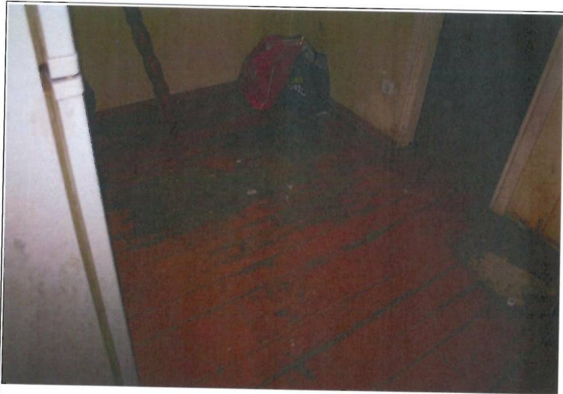
Foto Nr.3;4. Grīdu konstrukcijas telpās Nr.1. un Nr.2.
