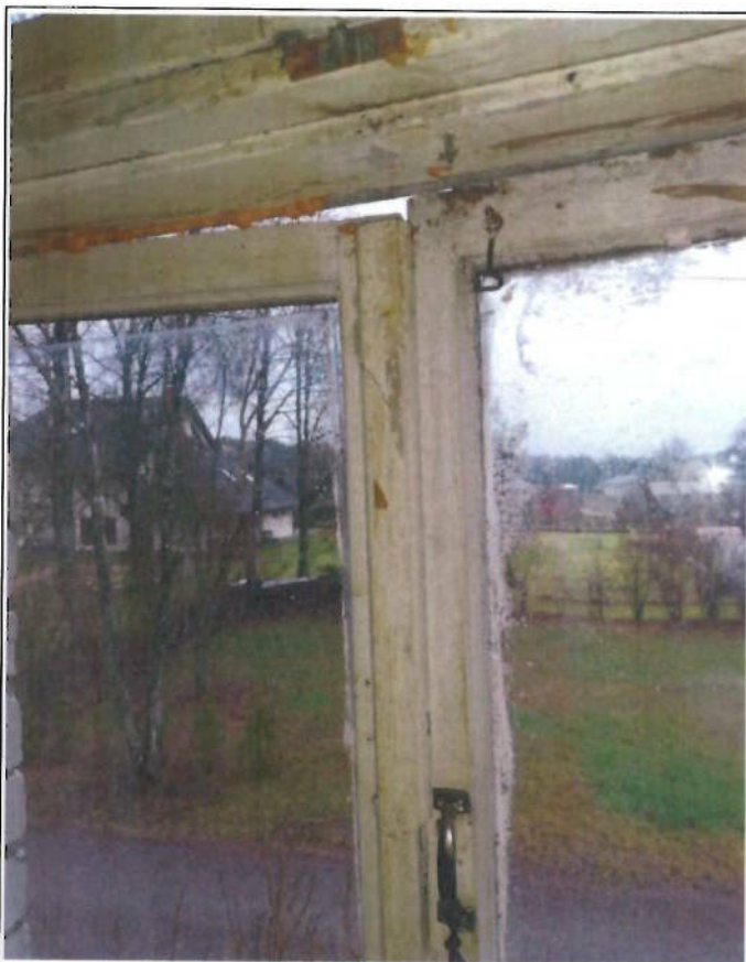
Foto Nr.11;12;13. Logu konstrukcijas.
