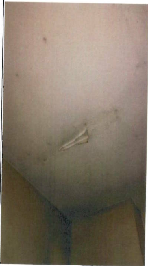
Foto Nr.1;2. Griestu konstrukcijas telpās Nr.1. un Nr.2.
