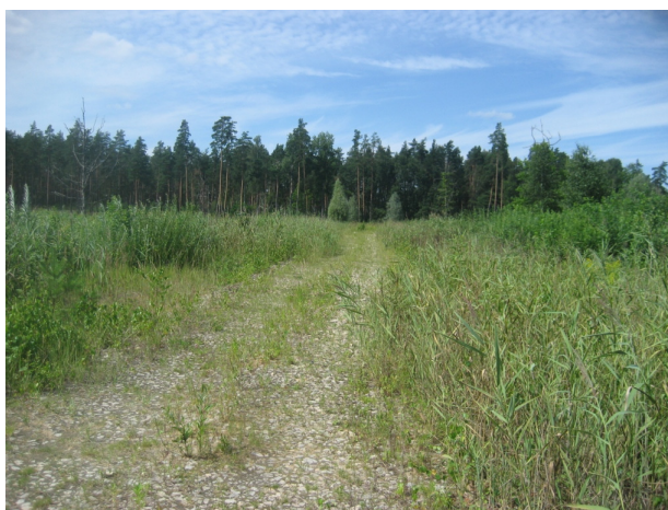
Foto Nr.2 Plānojamaajā teritorijā uzsāktā ielu izbūve
