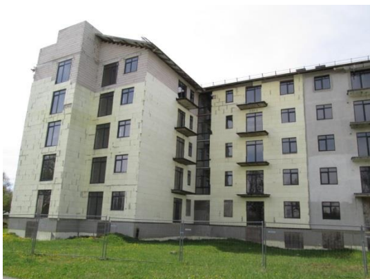
2.20.attēls. Uz daudzdzīvokļu dzīvojamās ēkas uzklātais siltumizolācijas materiāls nav pasargāts no apkārtējās vides negatīvās ietekmes
