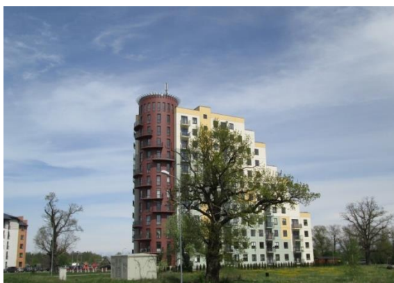
2.17.attēls. Daudzdzīvokļu dzīvojamā ēkā Ūbeļu ielā 13, Podniekos
