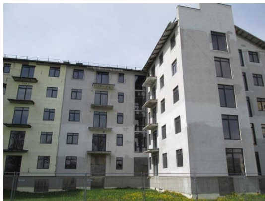
2.20.attēls. Uz daudzdzīvokļu dzīvojamās ēkas uzklātais siltumizolācijas materiāls nav pasargāts no apkārtējās vides negatīvās ietekmes
