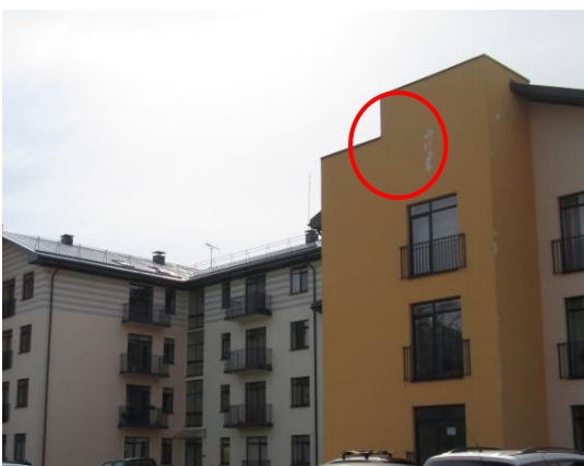
2.19.attēls. Atsevišķām ēkām Podniekos manāma apmetuma lobīšanās
