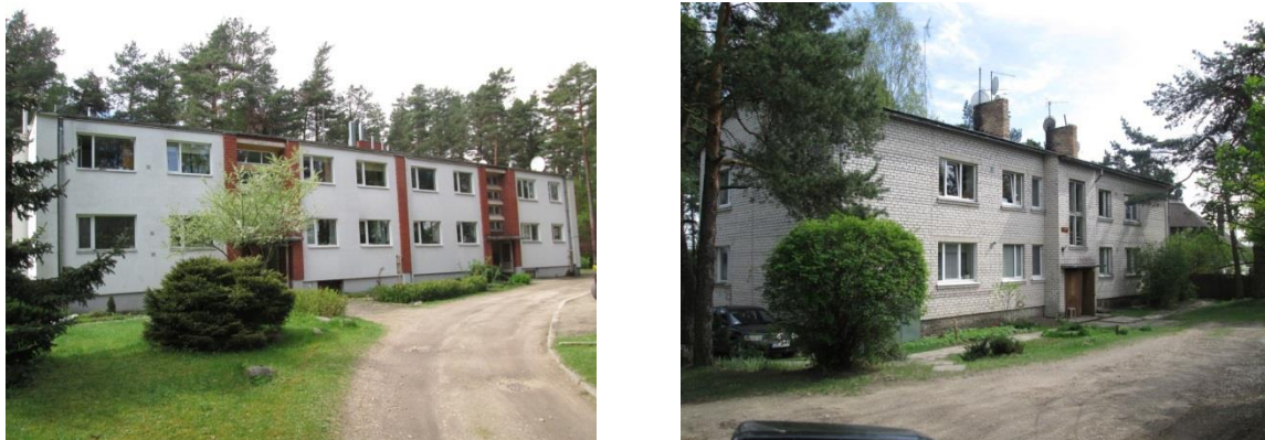
2.13.attēls. Baltezerā esošās daudzdzīvokļu dzīvojamās ēkas
