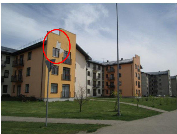
2.19.attēls. Atsevišķām ēkām Podniekos manāma apmetuma lobīšanās
